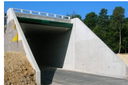
PIPO (Passage Inférieur en Portique Ouvert)
