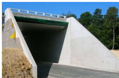
PIPO (Passage Inférieur en Portique Ouvert)
