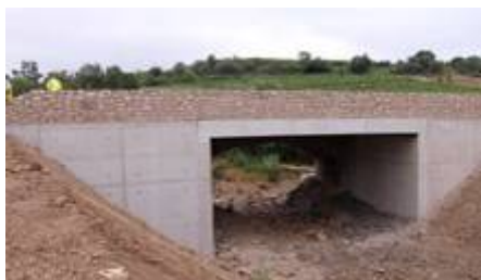
PICF (Passage Inférieur en Cadre Fermé).
