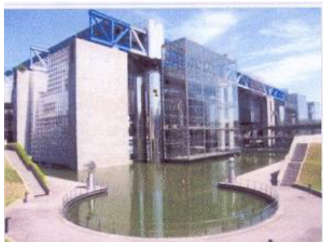
Vue extérieure de la Cité des sciences (côté Géode).
